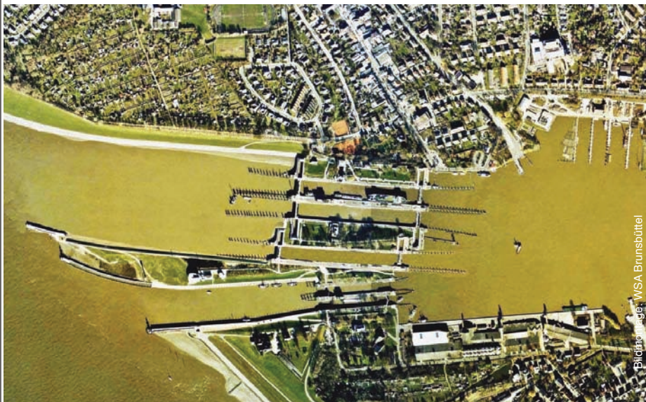
Die Mittel für den Bau der fünften Seeschleuse in Brunsbüttel (Bildmitte) sind frei gegeben worden. Die Fertigstellung ist für das zweite Halbjahr 2020 vorgesehen
